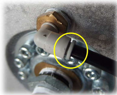
(8) ウレタンホースと貯水タンク本体の接続
